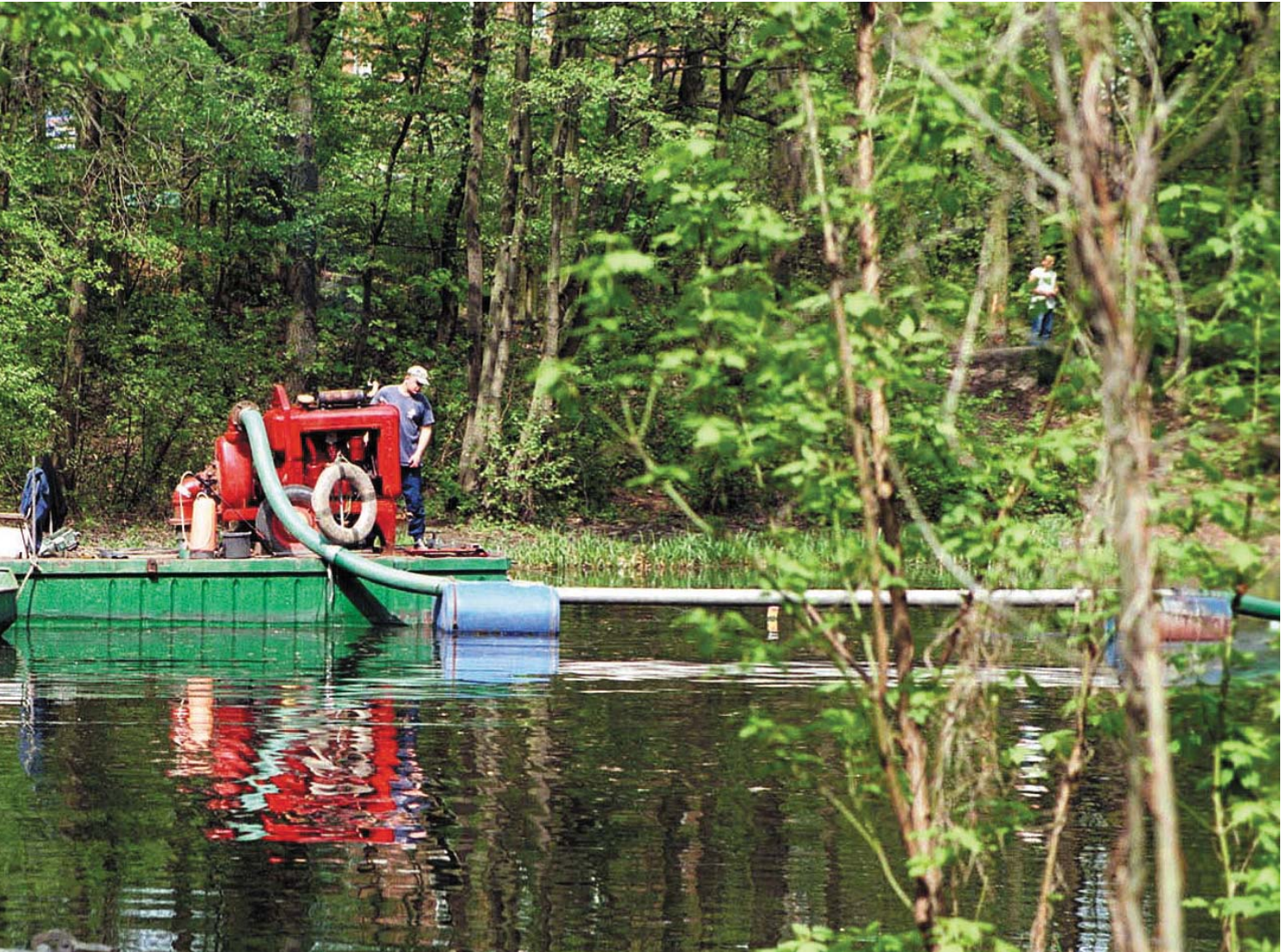
W trakcie prac rekultywacyjnych na Grundeli – refulerowanie dna
