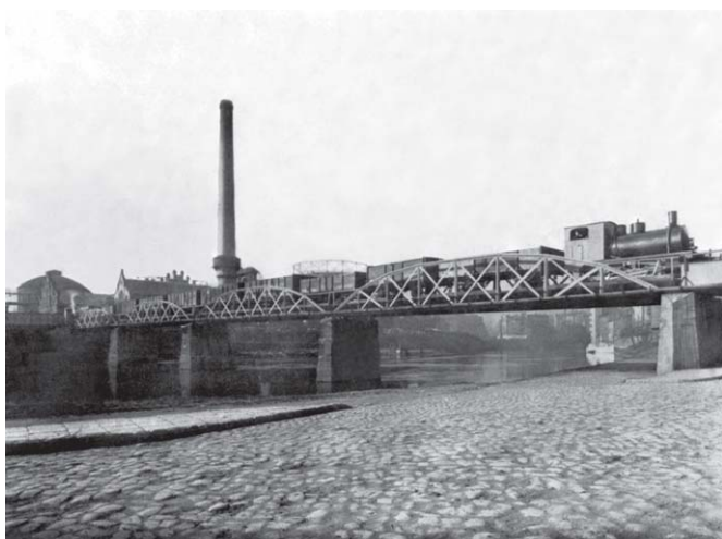
Gazownia poznańska miała własną bocznice kolejową z mostem przez Wartę – 1932 r.
