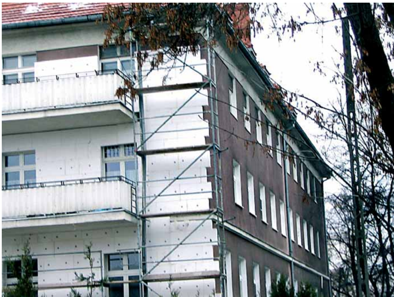
Przykład ograniczonych działań właściciela budynku – roboty dociepleniowe elewacji.
