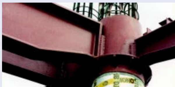
Głowice na słupach przydylatacyjnych
