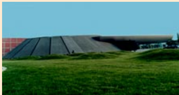
Fot. 10, 11. Widok wykonanego pokrycia dachowego
