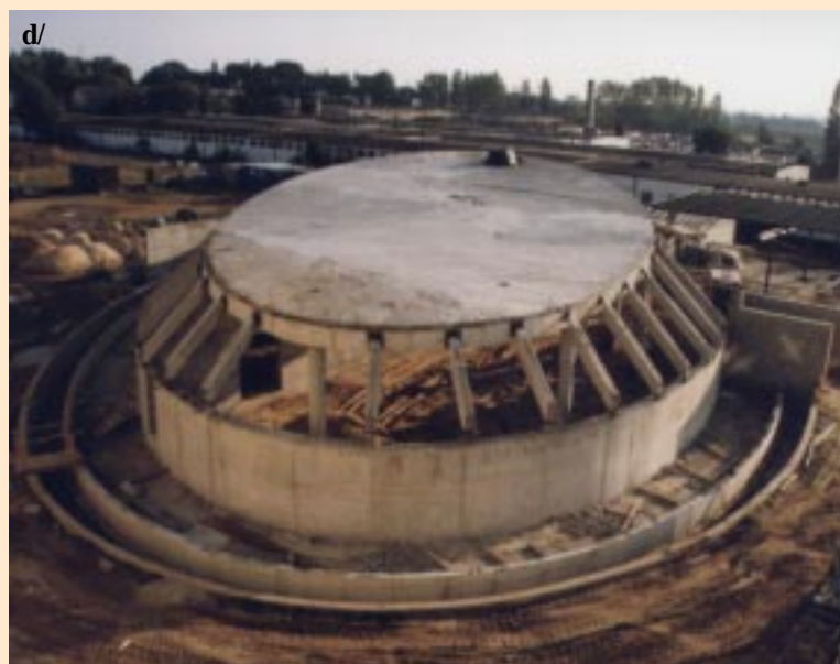
Fot. 5. Realizacja konstrukcji sklepu przykładowego firmy BIG STAR Ltd. a/ realizacja głównego pierścienia nośnego, b/ montaż żeber ukośnych (pobocznic), c/ montaż stropów Filigran , d/ ogólny widok głównego układu konstrukcyjnego
