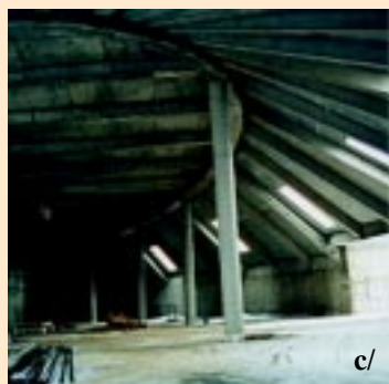
Fot. 5. Realizacja konstrukcji sklepu przykładowego firmy BIG STAR Ltd. a/ realizacja głównego pierścienia nośnego, b/ montaż żeber ukośnych (pobocznic), c/ montaż stropów Filigran , d/ ogólny widok głównego układu konstrukcyjnego
