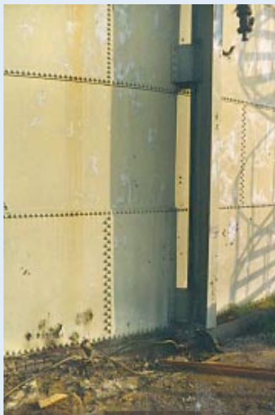
Rys. 3. Prowadnica zbiornika.
