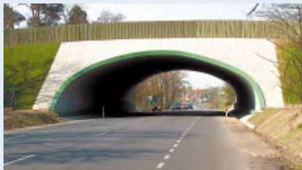
Rys. 1. Przykład konstrukcji podatnej z blach falistych dużej rozpiętości jako przejście ekologiczne.
