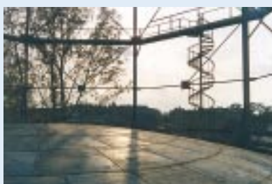
Rys. 5. Dach i drugi pomost.
