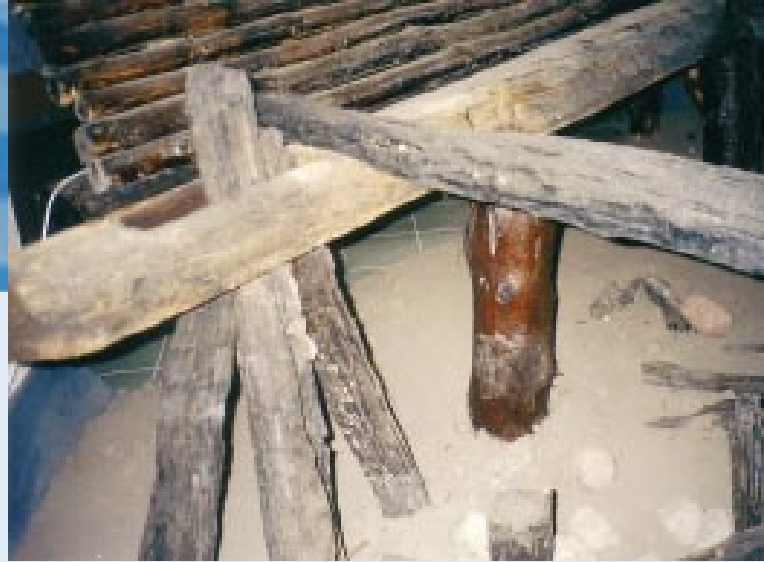
Rys. 3. Elementy Mostu Lednickiego wydobyte z dna jeziora - Muzeum Lednickie
