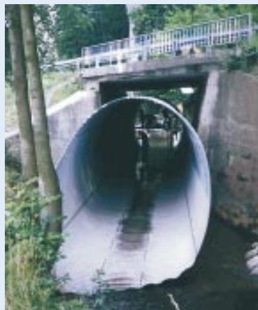
Rys. 1. Przykład konstrukcji podatnej z blach falistych dużej rozpiętości jako przejście ekologiczne.
