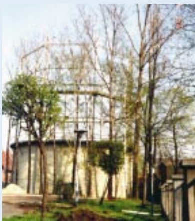
Rys. 2. Widok zbiornika przed adaptacją.
