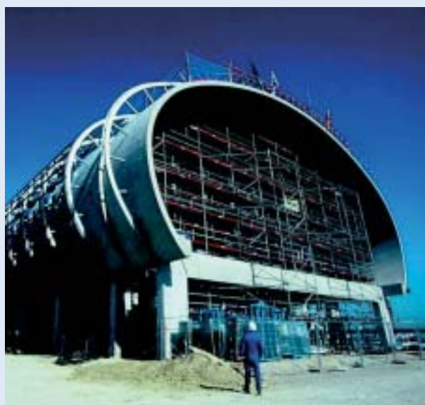
Rys. 7, 8. Terminal w czasie budowy [4]
