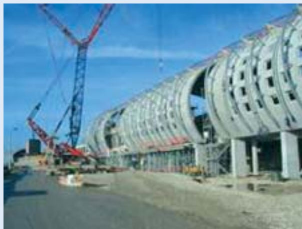
Rys. 6. Montaż zespolonego przekrycia terminalu [4]
