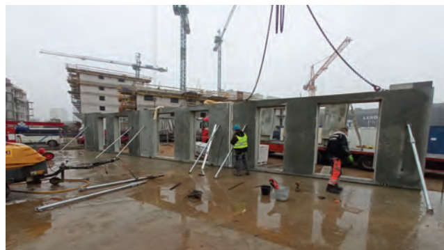
Montaż ścian prefabrykowanych bezpośrednio z samochodu dostawczego (w tle) bez konieczności magazynowania – tzw. „montaż z kół”.
