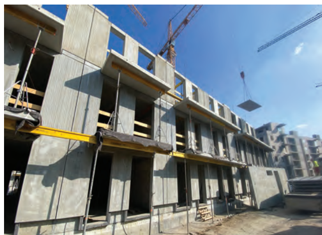
Zamontowane ściany zewnętrzne oraz balkony. Fot. HM Factory
