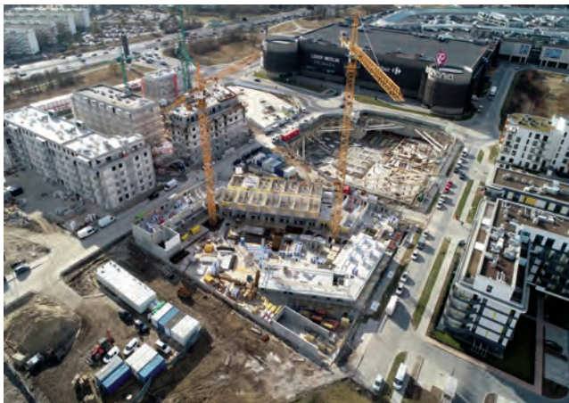
Budowa podczas montażu prefabrykatów. Fot. Grupa Inwest
