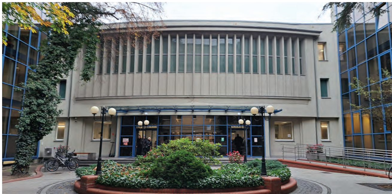
Budynek sądu w Poznaniu przy ulicy Marcinkowskiego 32. Fot. PINB
