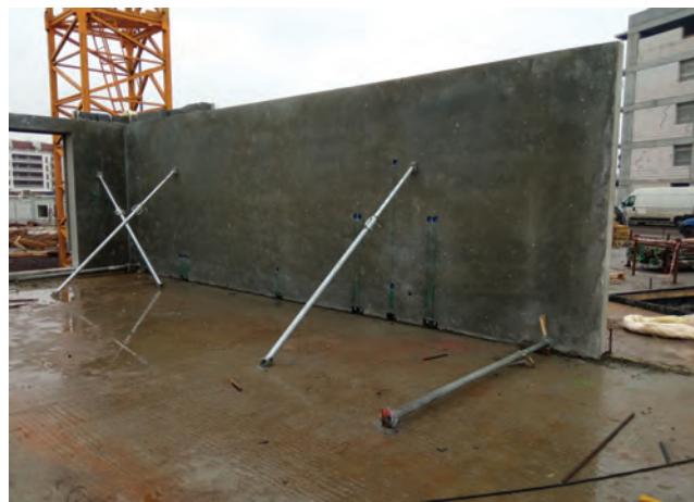
Ściana jednowarstwowa podczas montażu. Fot. Grupa Inwest
