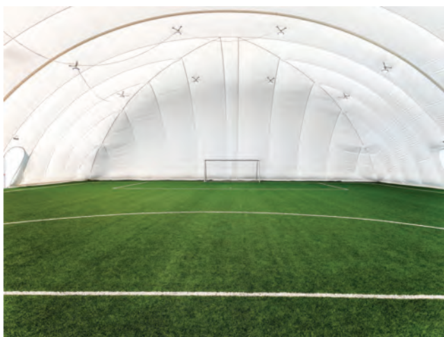
Wnętrze hali pneumatycznej dwupowłokowej nad boiskiem piłkarskim.
