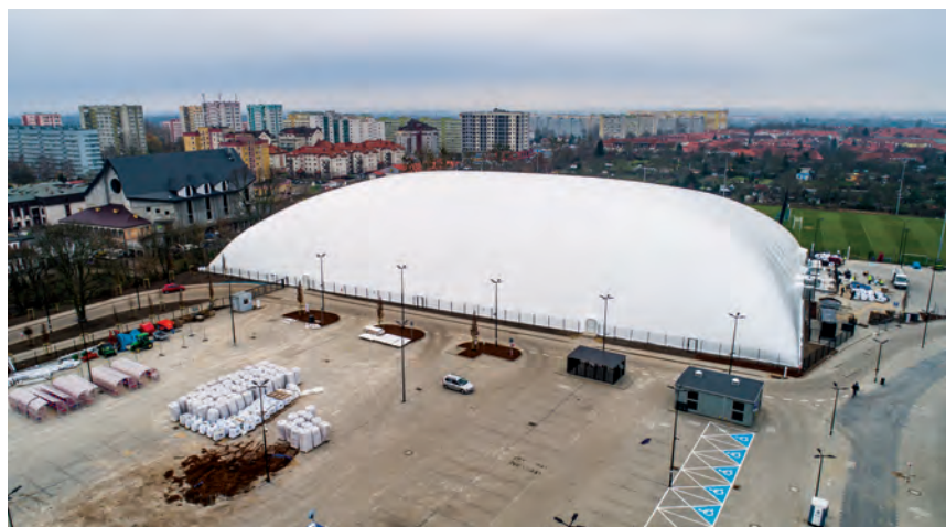
Widok z lotu ptaka na halę pneumatyczną dwupowłokową – Akademia Pogoń Szczecin (wymiar: 115 x 74 m).
