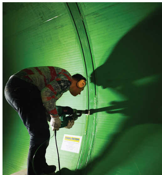
Już po zakończeniu etapu mikrotunelowania wewnętrzna wkładka PEHD jest dodatkowo spawana, co zapewnia jeszcze większą szczelność całego systemu. Fot. HABA-Beton Johann Bartlechner Sp. z o.o.
