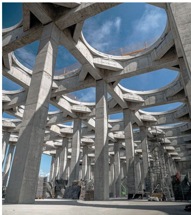
Jedna z realizowanych konstrukcji. Fot. JAKON
