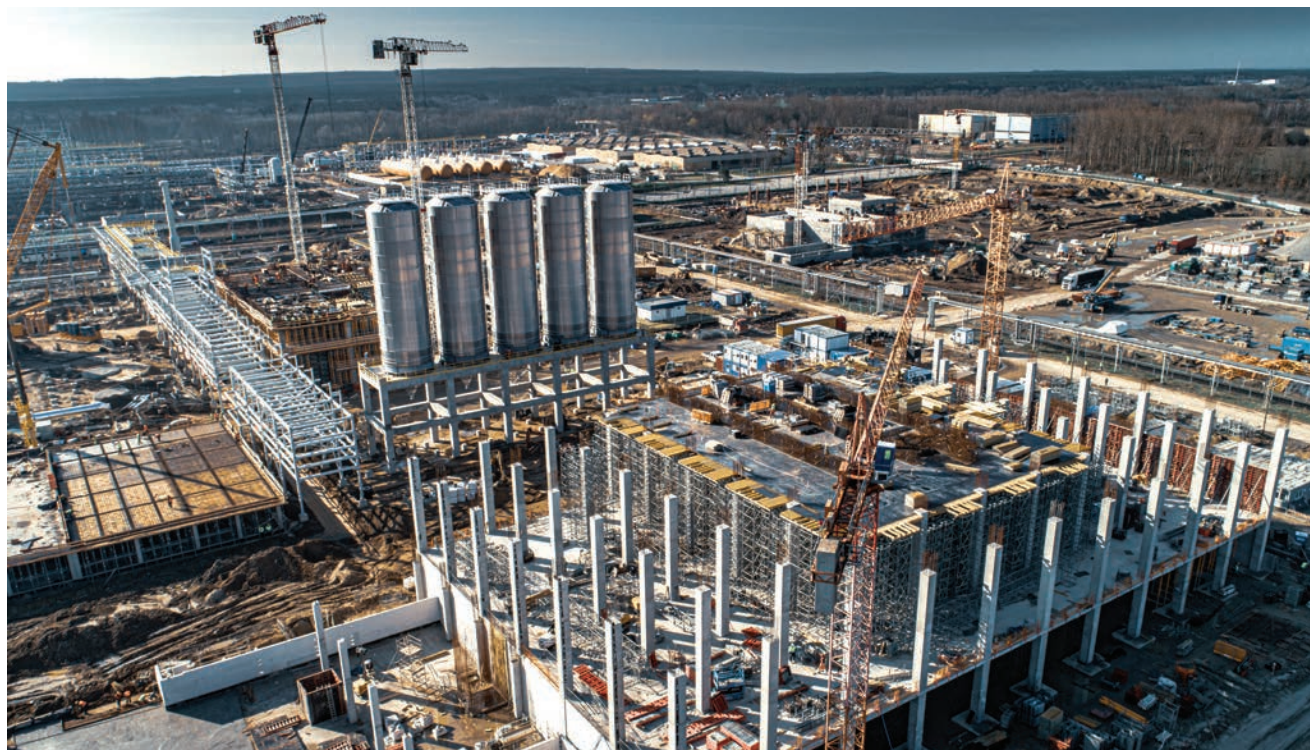
Budowa Polimery Police. Fot. PERI
