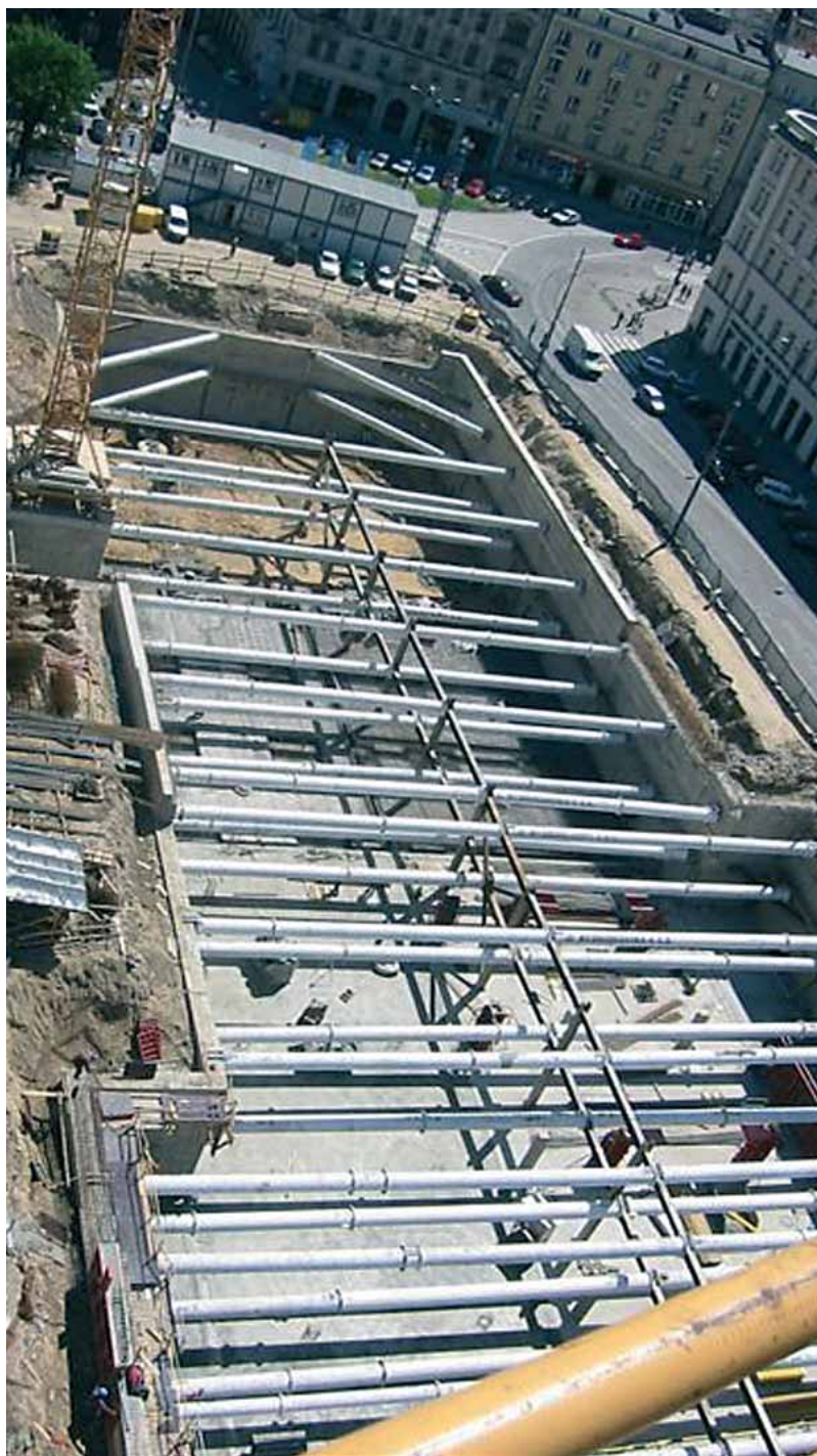
Przykład zabezpieczenia placu budowy
