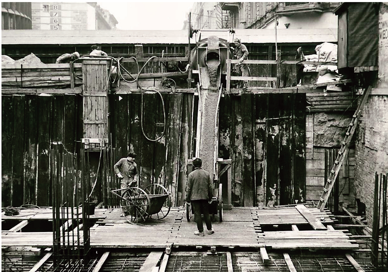
Zdjęcie nr 1. Budowa Domu Książki – część podziemna. Źródło [2] – fot. Z. Nowicki
